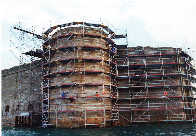
Das Bagerüst der Festung im Jahre 2002 — Het kasteel du Taureau in 2002 in de steigers
